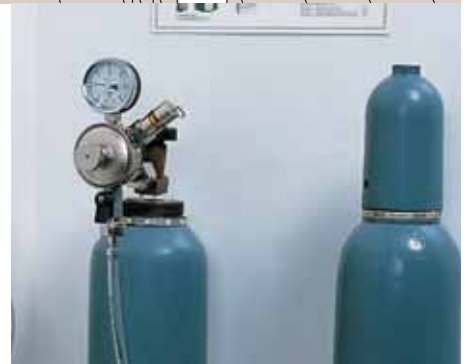
Die Flaschen mit der Kohlensäure müssen aufrecht stehen und sicher an der Wand befestigt sein.
