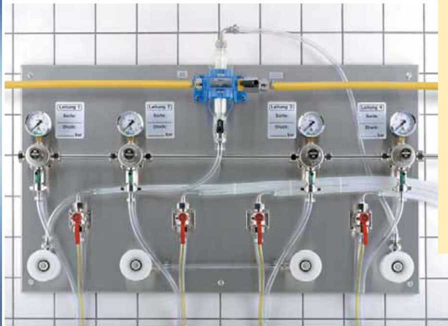
Wenn Sie mehrere Biersorten am Hahn haben, ist es wichtig, die Leitungen im Keller eindeutig zu kennzeichnen.
